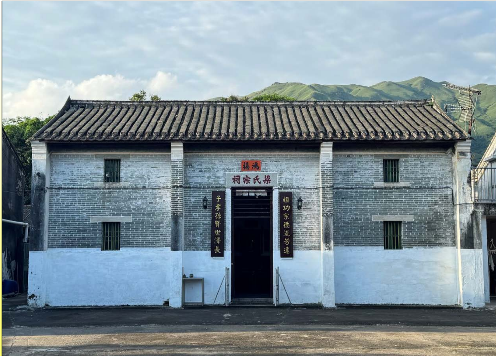
建築物的外部 Exterior of the building
